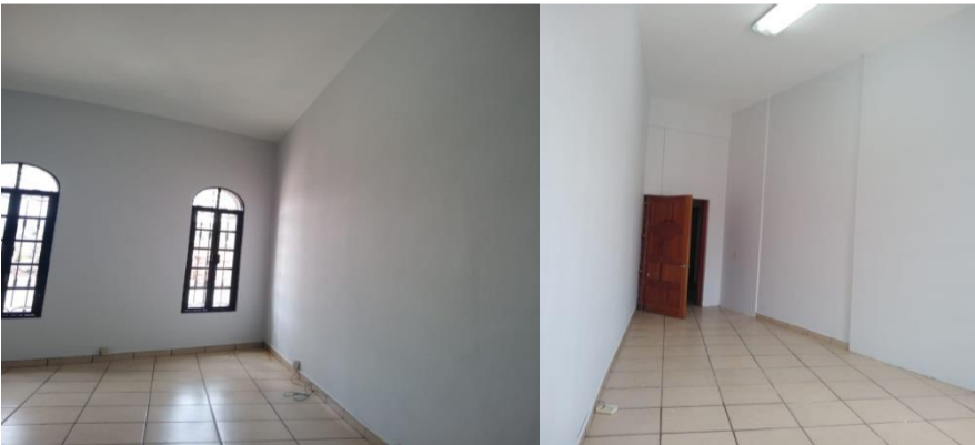
Se rehabilito oficina de Reglamentos.
