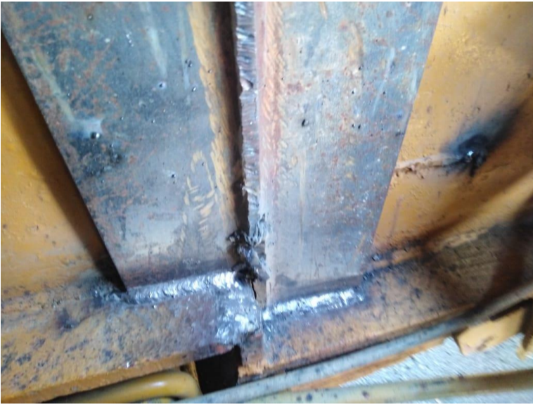
Se reparó cama baja de volteo
