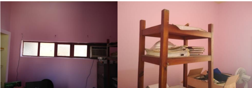
Se rehabilito oficina del Juez Menor.
